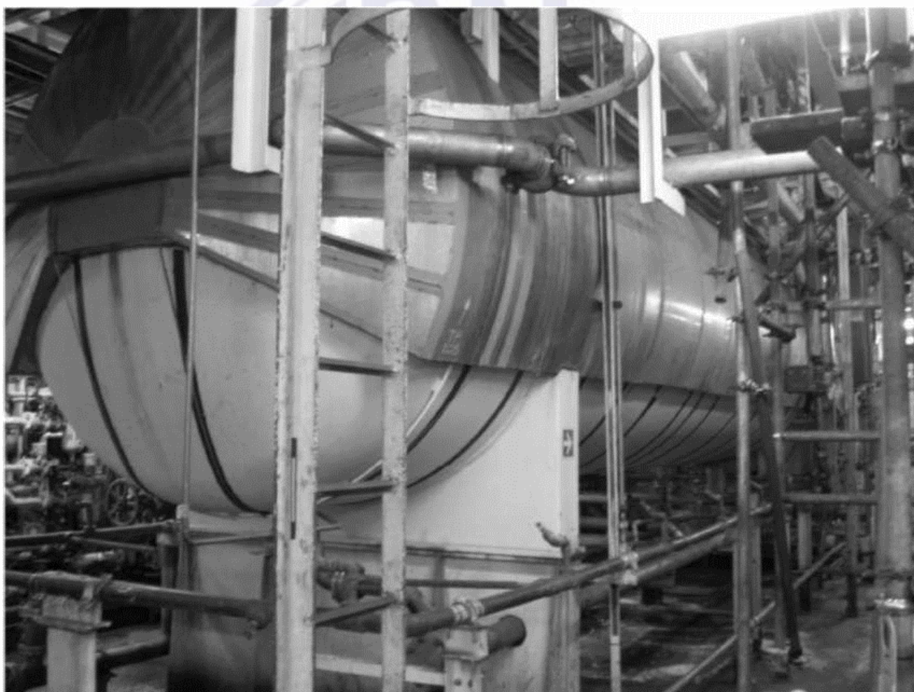
Figura F.2 – Estruturas acima do vaso dificultando o acesso
