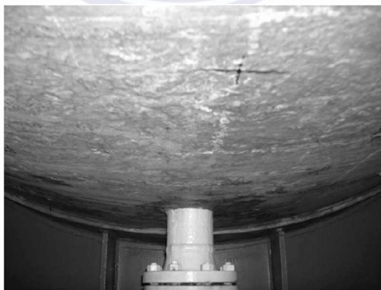
Figura F.6 – Áreas com corrosão ou com más condições superficiais afetando a inspeção por CHIME
